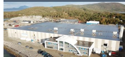
Innhavet RAS facility
